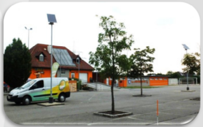
Solar Parkplatzbeleuchtung Gössendorf GAIA 150, 20 Watt LED
