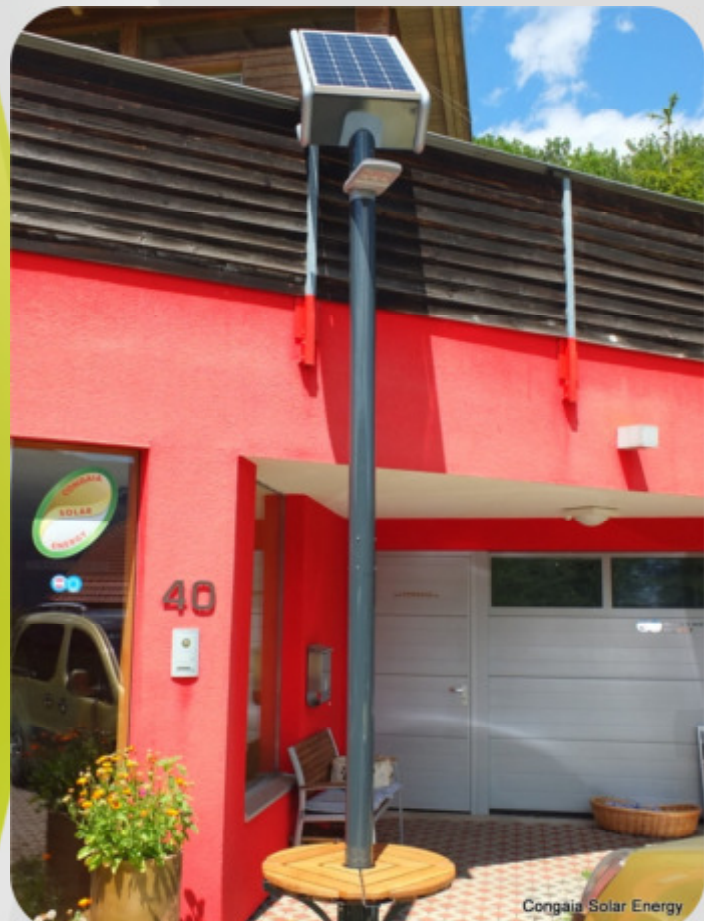
Congaia Meetingpoint, Ladeinfrastruktur für Handy und Fahrrad, Beleuchtung und Wlan Hotspot
