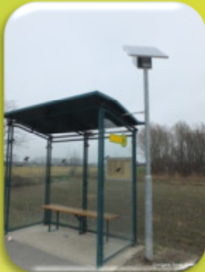
Solar Buswartehaus Beleuchtung Ebreichsdorf
